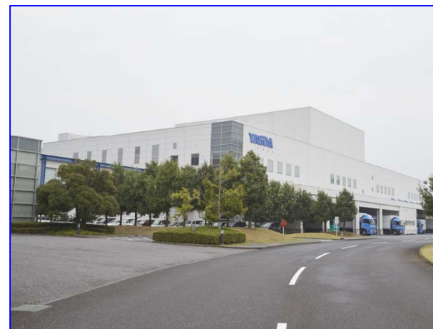
メディカル物流ユニット 東京物流センター
