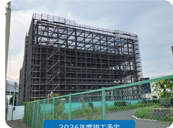
▽ (仮称)羽田営業所 建設工事進行
