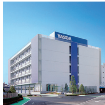
〈守屋町C号ビル〉
