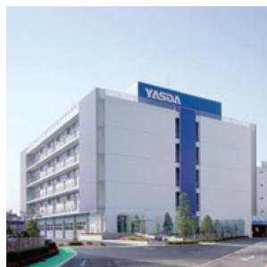
〈守屋町C号ビル〉
