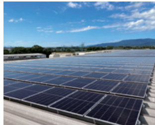
九州営業所屋上
