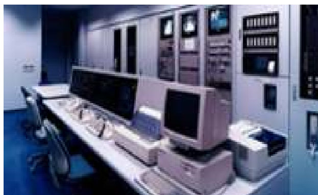
ビルメンテナンス
