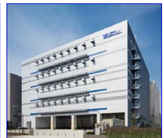
平和島営業所 第二倉庫
