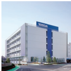
〈守屋町C号ビル〉
