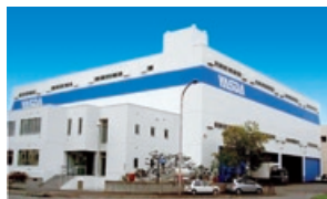
〈北海安田倉庫札幌中央センター〉
