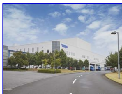
メディカル物流ユニット 東京物流センター
