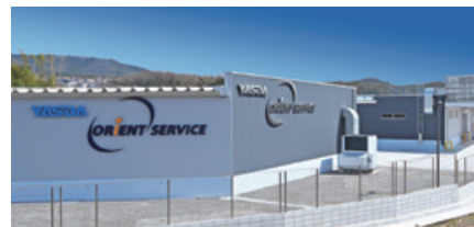
明知物流センター危険物倉庫
