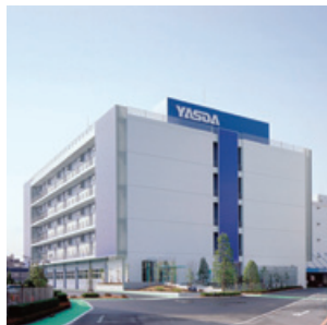
〈守屋町C号ビル〉
